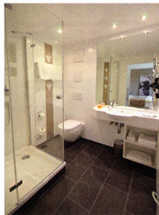
Die neuen Bäder sind Fertigmodule.
